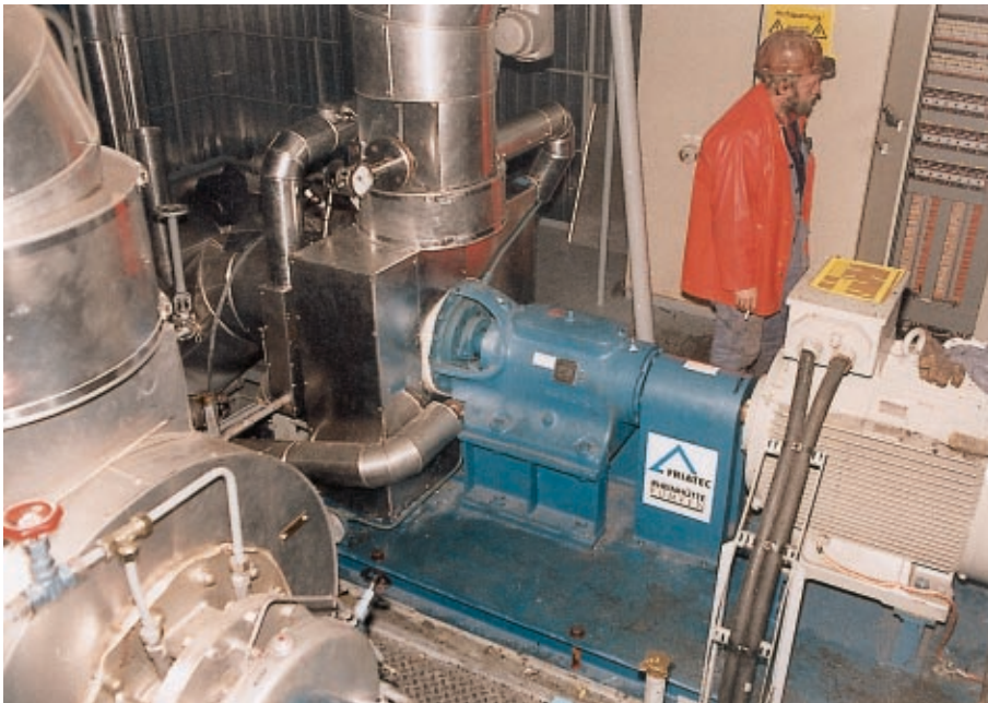
RCE-Pumpen mit installierter Dampfheizung zur Förderung von Pech auf einem Pechtanker RCE pump with steam heating for pumping pitch on a pitch tanker Pompe RCE avec réchauffage vapeur pour le pompage de brai sur un navire-citerne.
